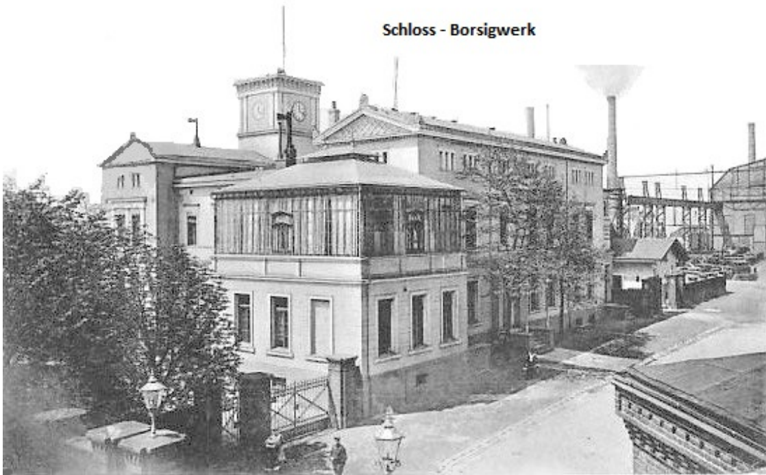
Hier ist das Institut eingezogen (Bruders Arbeitsplatz)
